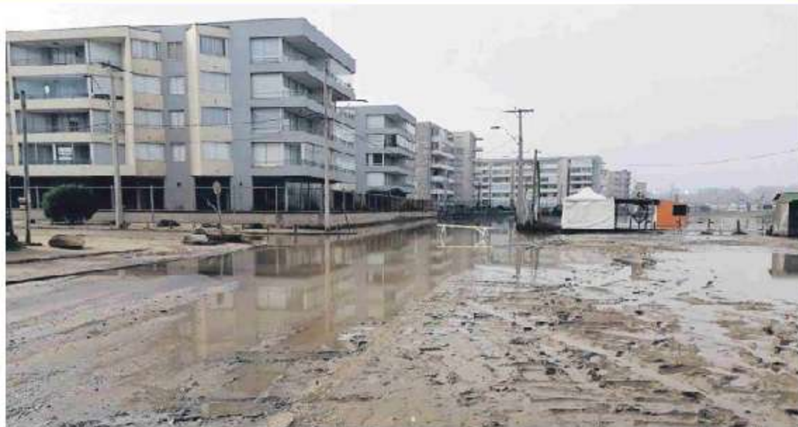
Condominios se levantaron en una zona de desborde del humedal
