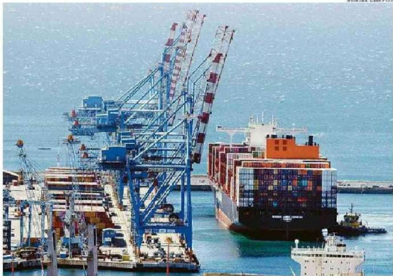
PUERTOS DE VALPARAÍSO Y SAN ANTONIO TRABAJAN EN LA AMPLIACIÓN DE SU CAPACIDAD DE CARGA.
