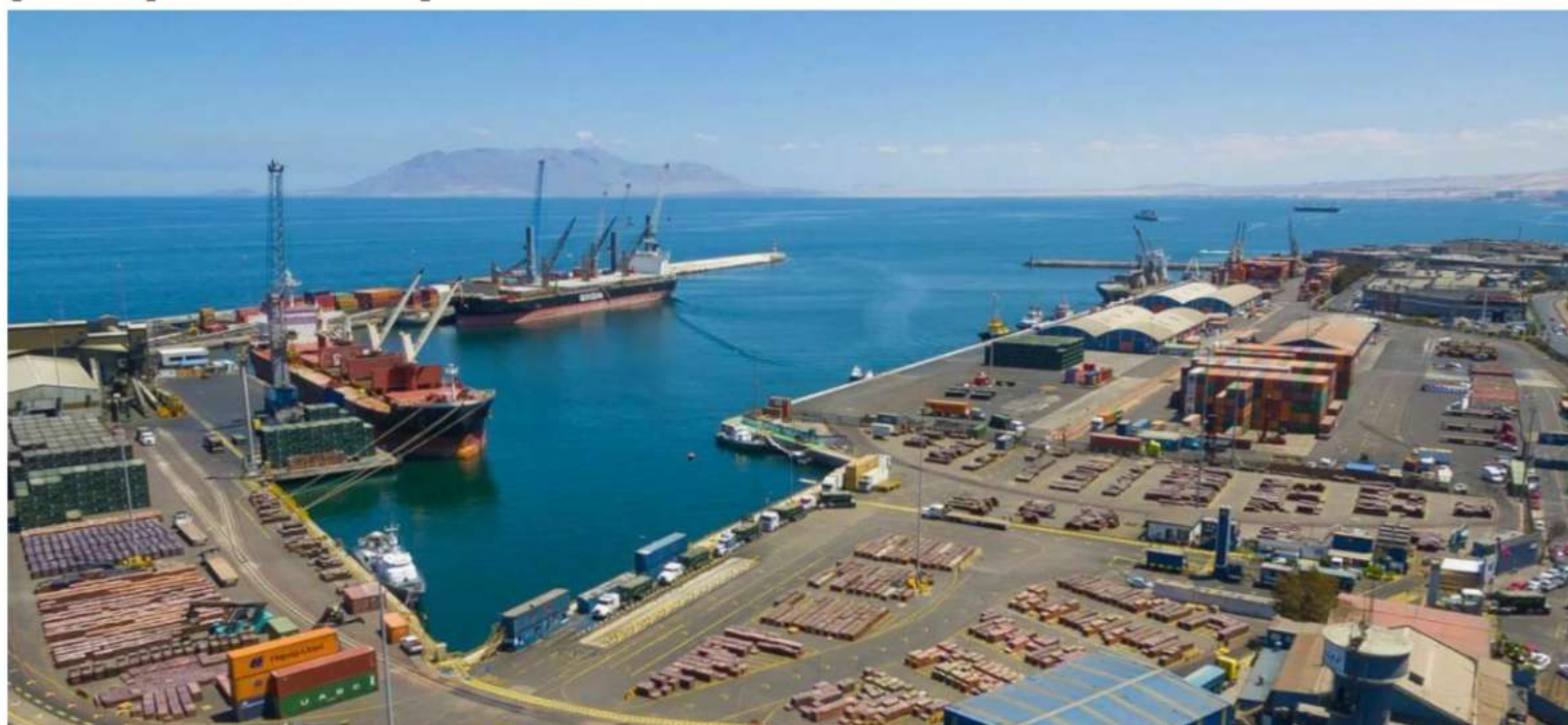
El Puerto de Valparaíso tiene una alta eficiencia en cuanto a la carga que transporta. Foto: AIA
