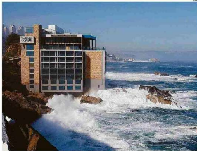
DESDE LA SEREMI DE VIVIENDA EMANÓ ESTE JUEVES UNA ORDEN DE DEMOLICIÓN PARA EL HOTEL DE 10 PISOS.
