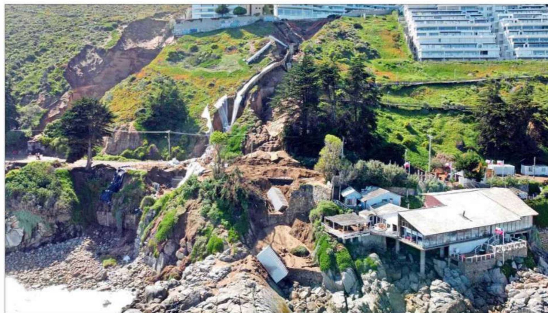
EN ZONA DE RIESGO.— Los edificios desocupados por seguridad quedaron justo enfrente, cerro arriba, del restaurante, causando inquietud en sus ocupantes.
