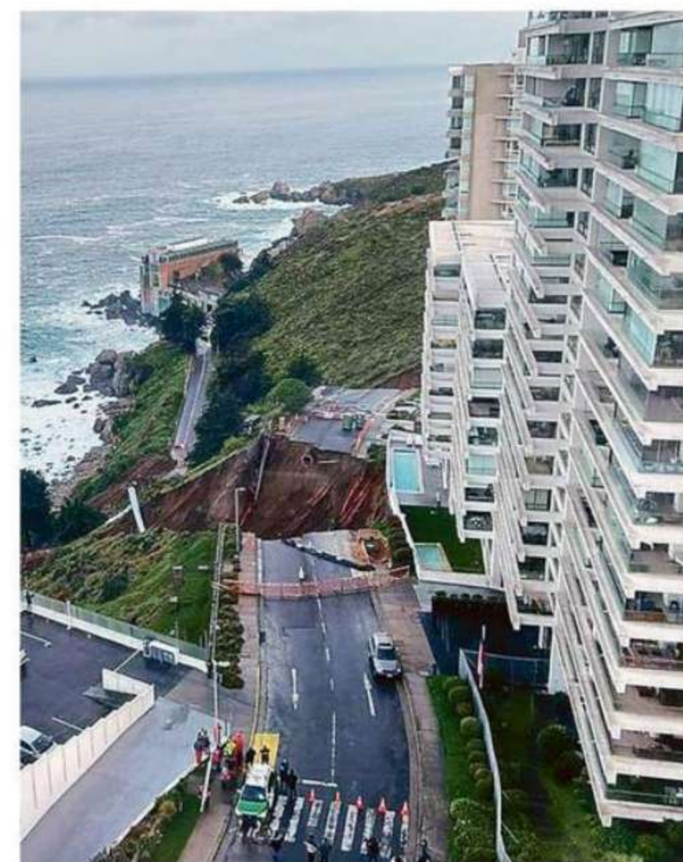
EL NUEVO SOCAVÓN DERIVÓ EN LA EVACUACIÓN DE OTROS EDIFICIOS.
