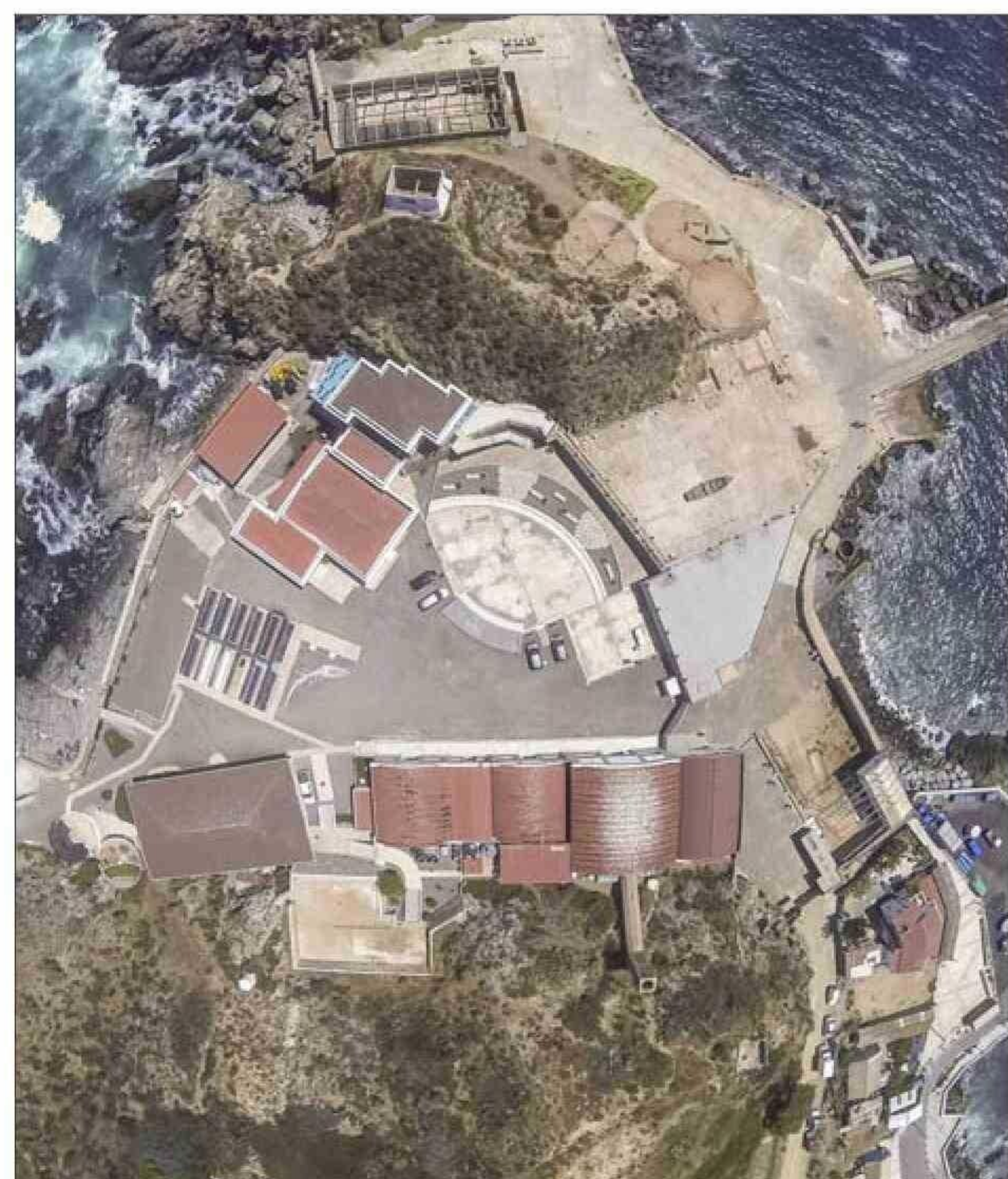
Vista aérea instalaciones CIMARQ.
